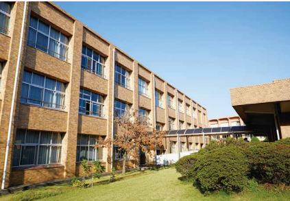
●普通教室の他、調理室・化学室・進路自習室 などがある高校棟
